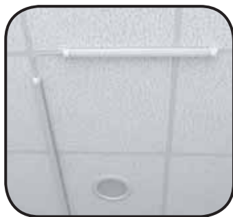
Ukázka zabočení s kabelovou propojkou
